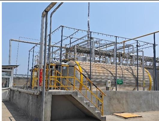
图 4-1.2 液氨储罐
